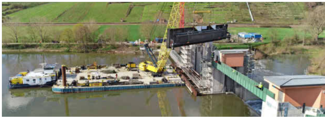
Riesige Dimensionen: Ende März hat das Wasserstraßen-Neubauamt Heidelberg das zweite von insgesamt drei Verschlüssen ins Horkheimer Wehr eingesetzt. Foto: WNA Heidelberg
