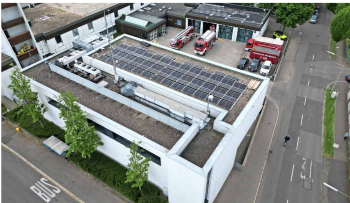
Auch auf der Integrierten Leitstelle produziert nun eine PV-Anlage Sonnenstrom.
