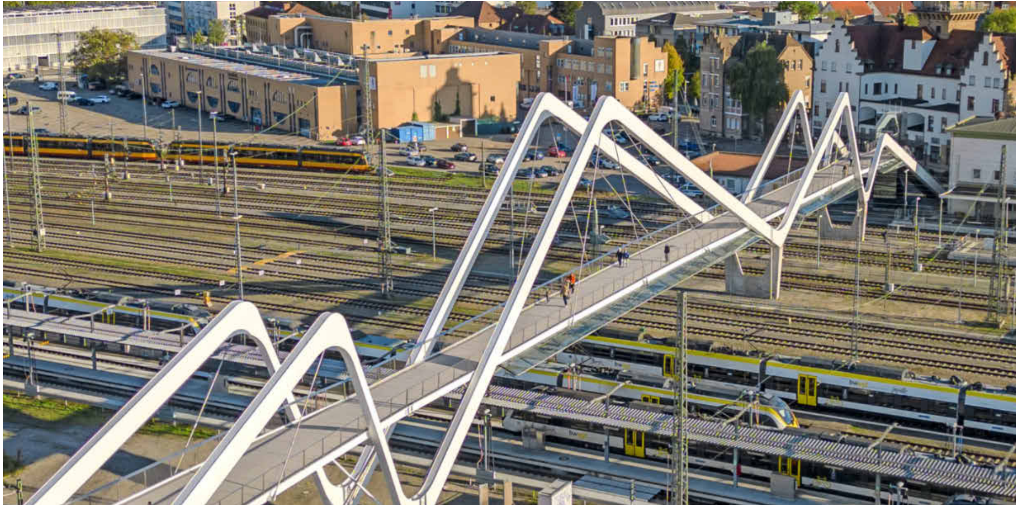
Die BUGA-Brücke spannt sich vom neuen Stadtquartier Neckarbogen über die Gleise der Bahn zur Bahnhofsvorstadt.
