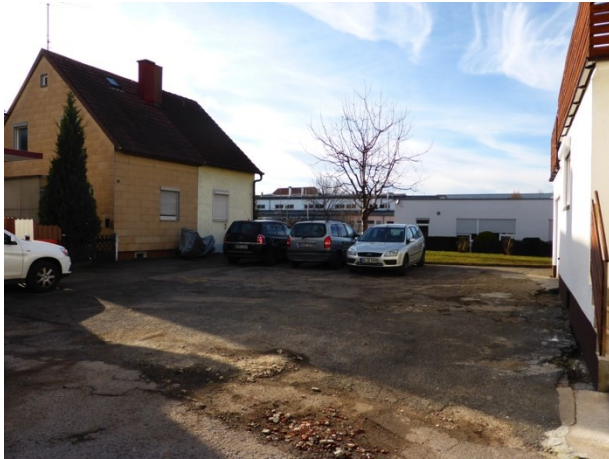
Abb. 19: Zustand Privatstraße; Zugang zu öffentlicher Grünfläche „Grünes Zimmer“
