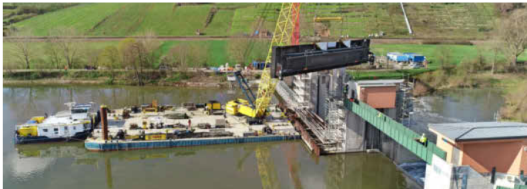
Riesige Dimensionen: Ende März hat das Wasserstraßen-Neubauamt Heidelberg das zweite von insgesamt drei Verschlüssen ins Horkheimer Wehr eingesetzt. Foto: WNA Heidelberg
