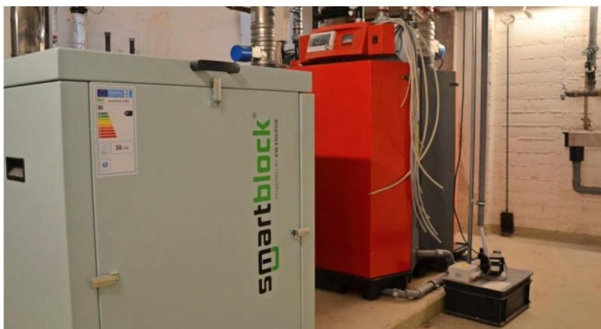
Abb. 18: Neues BHKW mit Brennwertkessel im Technischen Schulzentrum, P-Bau
