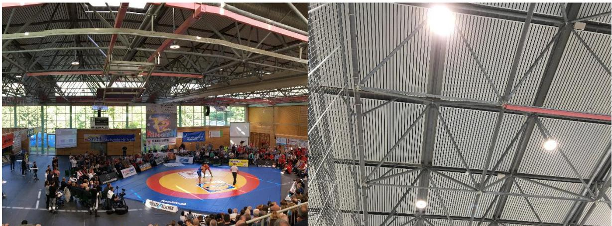
Abb. 19: Modernisierte Beleuchtung mit LED in der Römerhalle
